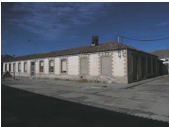
Fotografía 18: Edificio de las escuelas en Cabezuela.
